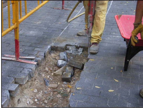
FOTO 1. Obertura de la rasa amb martell pneumàtic.
