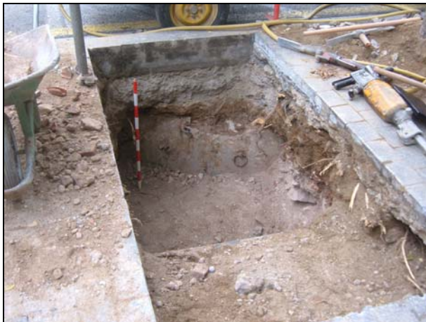
FOTO 11. Cala al Sector 4. UE 403. Mur.
