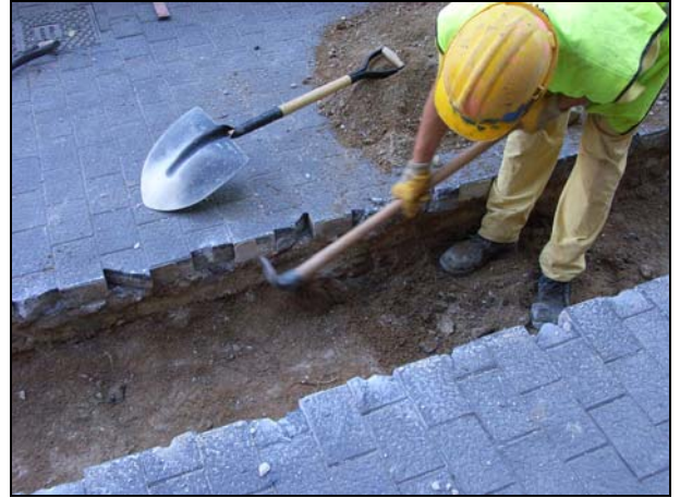
FOTO 2. Obertura de la rasa a mà..
